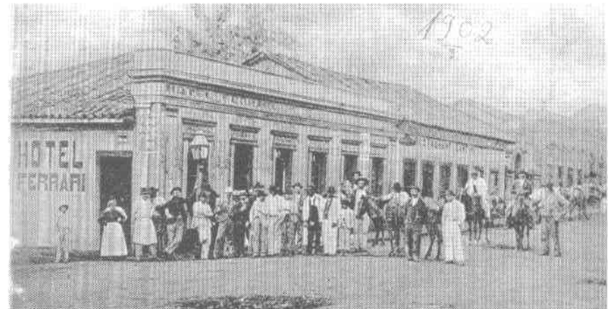
Rua Riachuelo (atual Amando de Barros), confluência com Coronel Fonseca. Da esquerda para a direita, nº 8 (esquina), Hotel Ferrari (antes fora Padaria Progresso), prédio de José Manoel de Arruda Campos; nº 10, Restaurant Santini, também Armazem de Seccos e Molhados (o prédio era de Tito Correa de Mello); nº 12, Casa Cardoso, junto com prédio de residência, de Antonio Joaquim Cardoso de Almeida, pai do advogado Dr. José Cardoso de Almeida, com escritório no nº 14. Lampeão de querosene na esquina.
