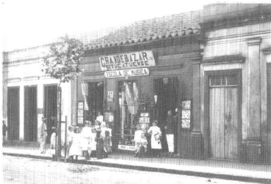
C. 1910 - Rua Riachuelo, nº 52, Bazar de Modesto Tognozzi (o proprietário do prédio era o velho Manoel Theodoro de Aguiar, pessoa importante desde a fundação da vila). O nº 50, à esquerda, era o Armazém Progresso, de Abílio de Almeida. O nº 54, à direita, foi a Barbearia de José Salomoni até 1909. Entre Marechal Deodoro e Mons. Ferrari, direita de quem desce.
