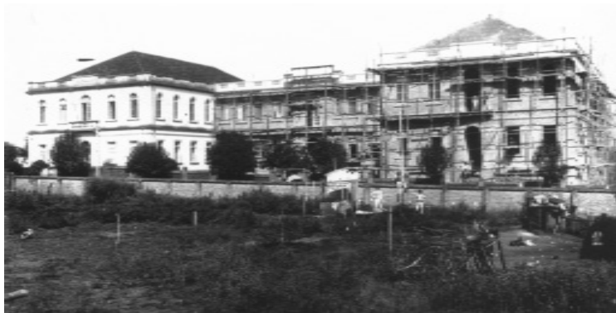
C. 1925. Construção dos últimos módulos do Collegio dos Anjos.
