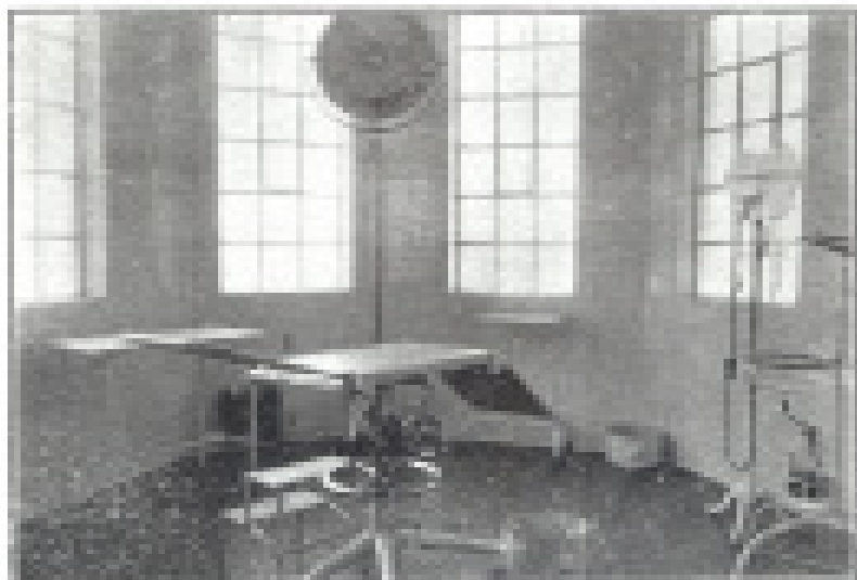
SALA DE OPERAÇÕES
