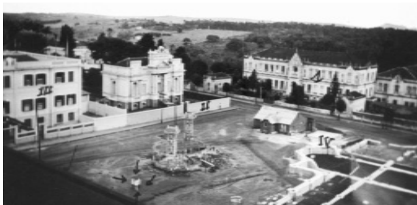
A Catedral em construção. c. 1938
